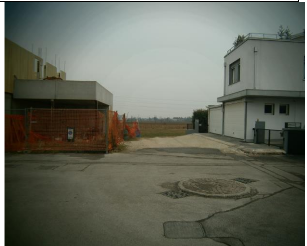
Foto 4 : strada sul sedime mn 1189
