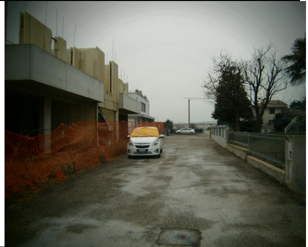
Foto 2: strada sul mn 1188
