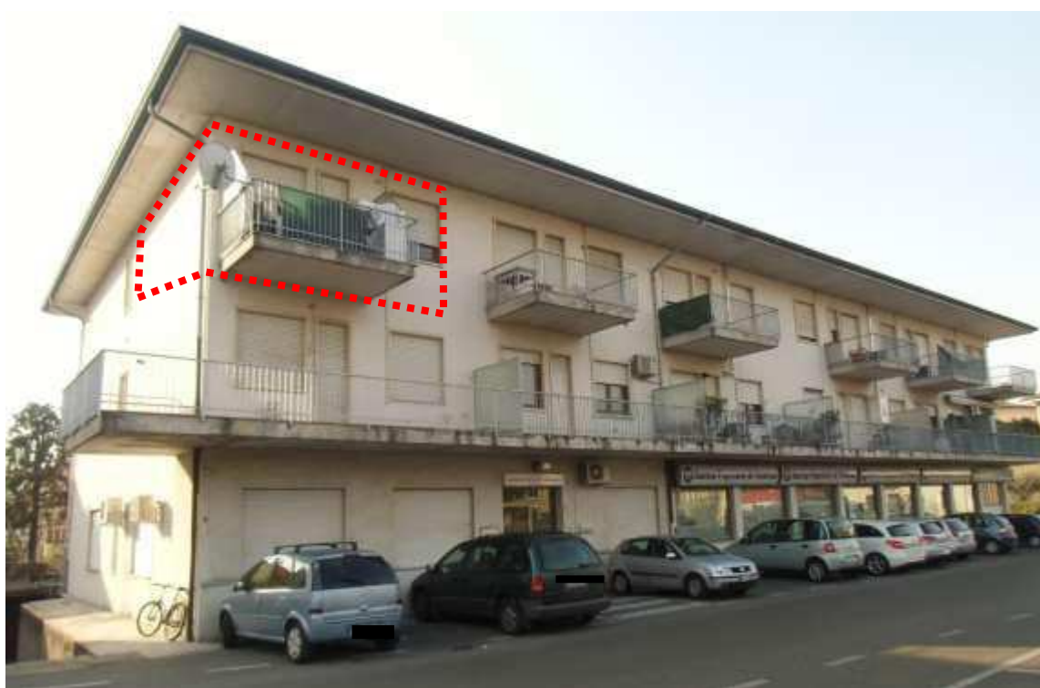
Foto n.1-2: vista Nord-Est edificio – da Via Giovanni Fincato
