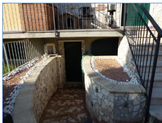
14. Accesso al garage dall'ingresso
