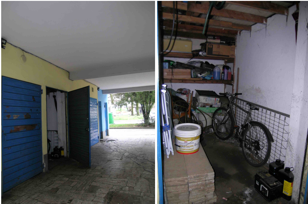
Viste della cantina al piano terra
