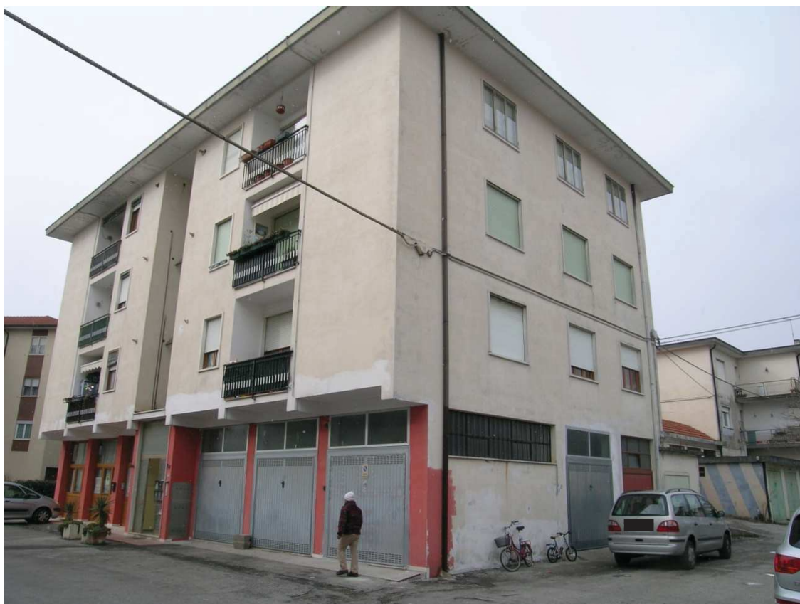
2) Il fianco destro dell'edificio
