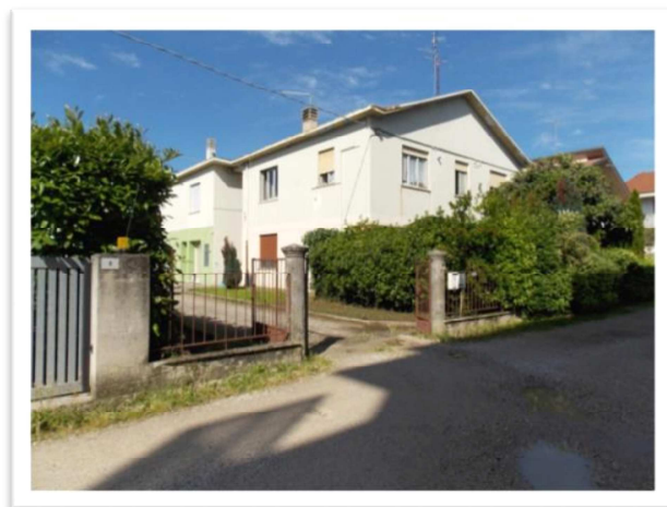
2 Vista da via Volta, lati nord-est e sud-est.
