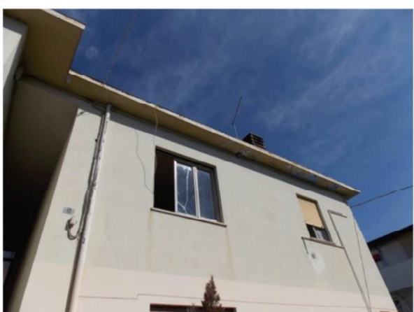
4 Vista lato sud-est, dettaglio sul piano primo
