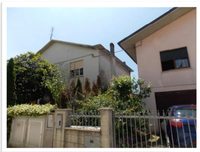
7 spigolo nord del fabbricato e nicchie contatori
