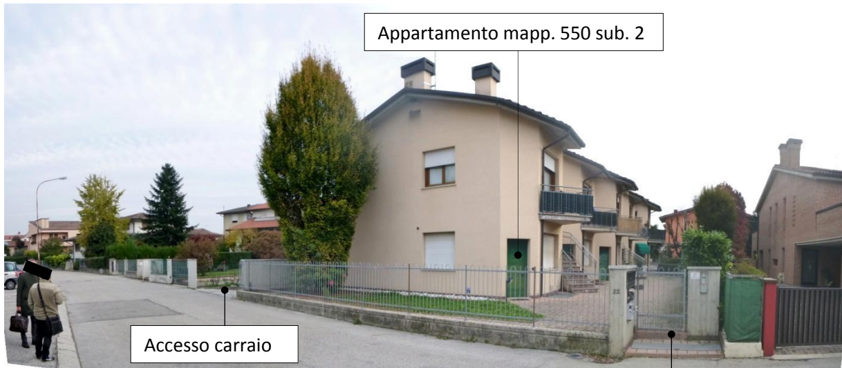
Fabbricato Fg. 13 mappale 550 – lato Sud/Ovest
