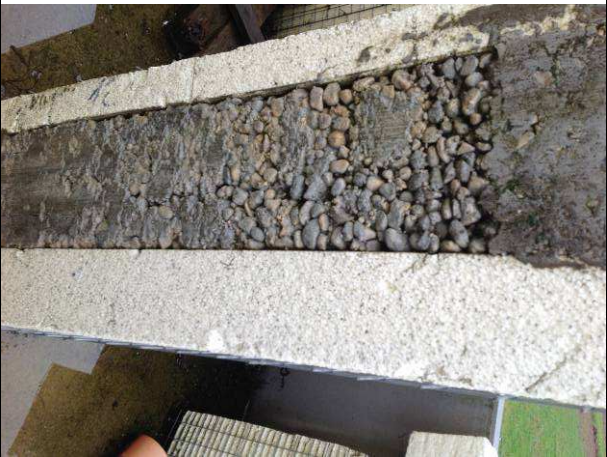
Foto 11: particolare composizione calcestruzzo armato
