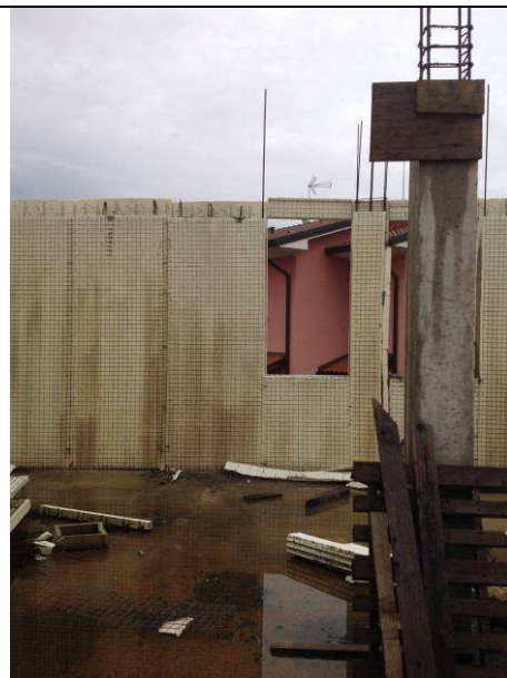
Foto 10: particolari dello stato realizzato
