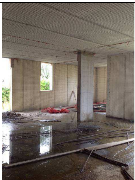
Foto 7: particolari dello stato realizzato
