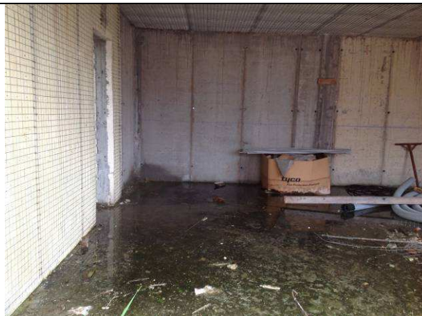
Foto 6: particolari dello stato realizzato
