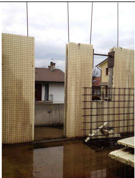
Foto 9: particolari dello stato realizzato
