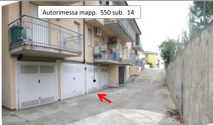
Fabbricato Fig. 13 mappale 550 – corsia di accesso alle autorimesse lato Nord
