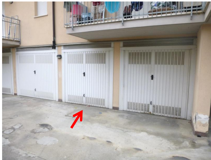
Accesso all'autorimessa mappale 550 sub. 14
