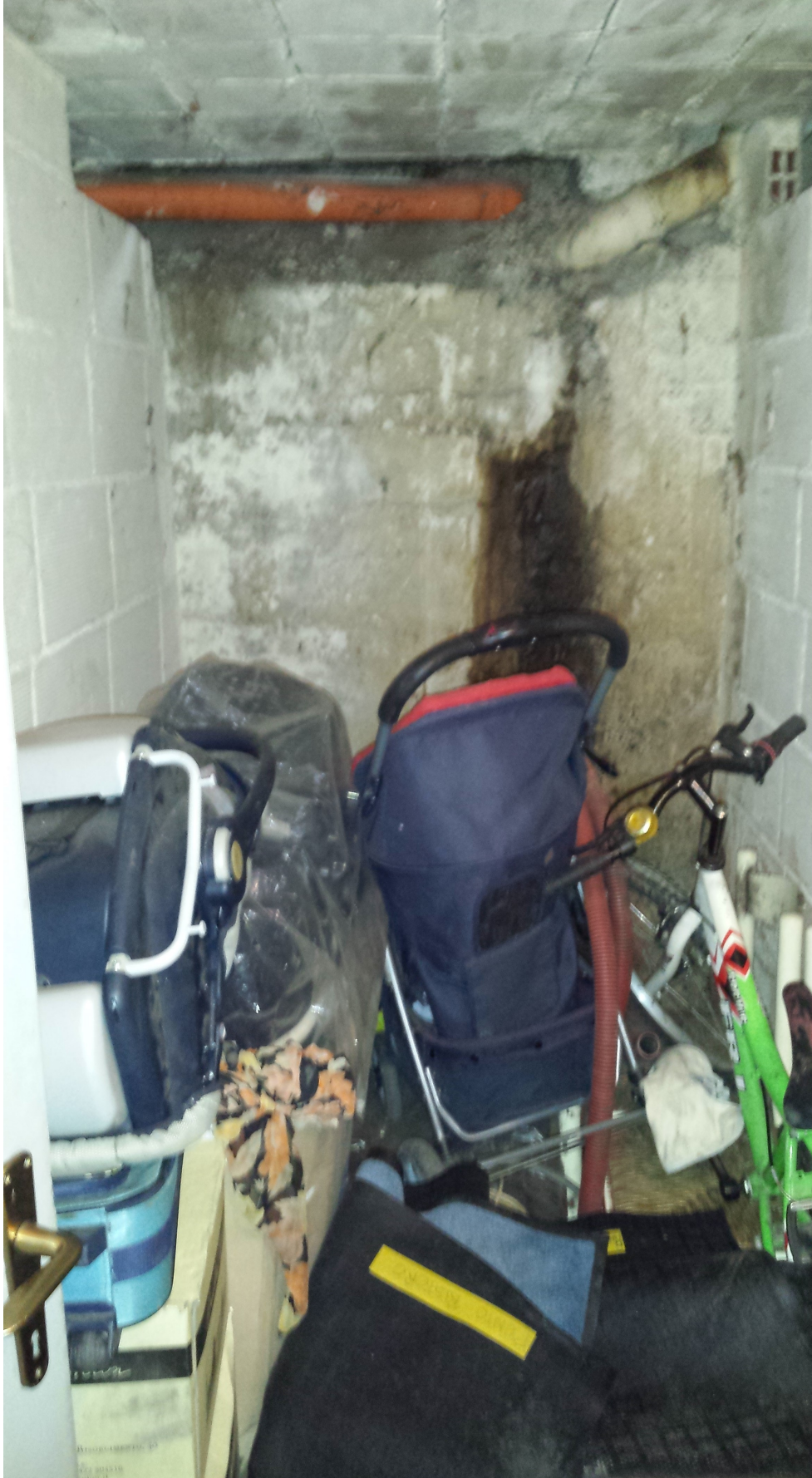
FOTO 2 – CANTINA ESCLUSIVA PIANO SOTTOSTRADA
