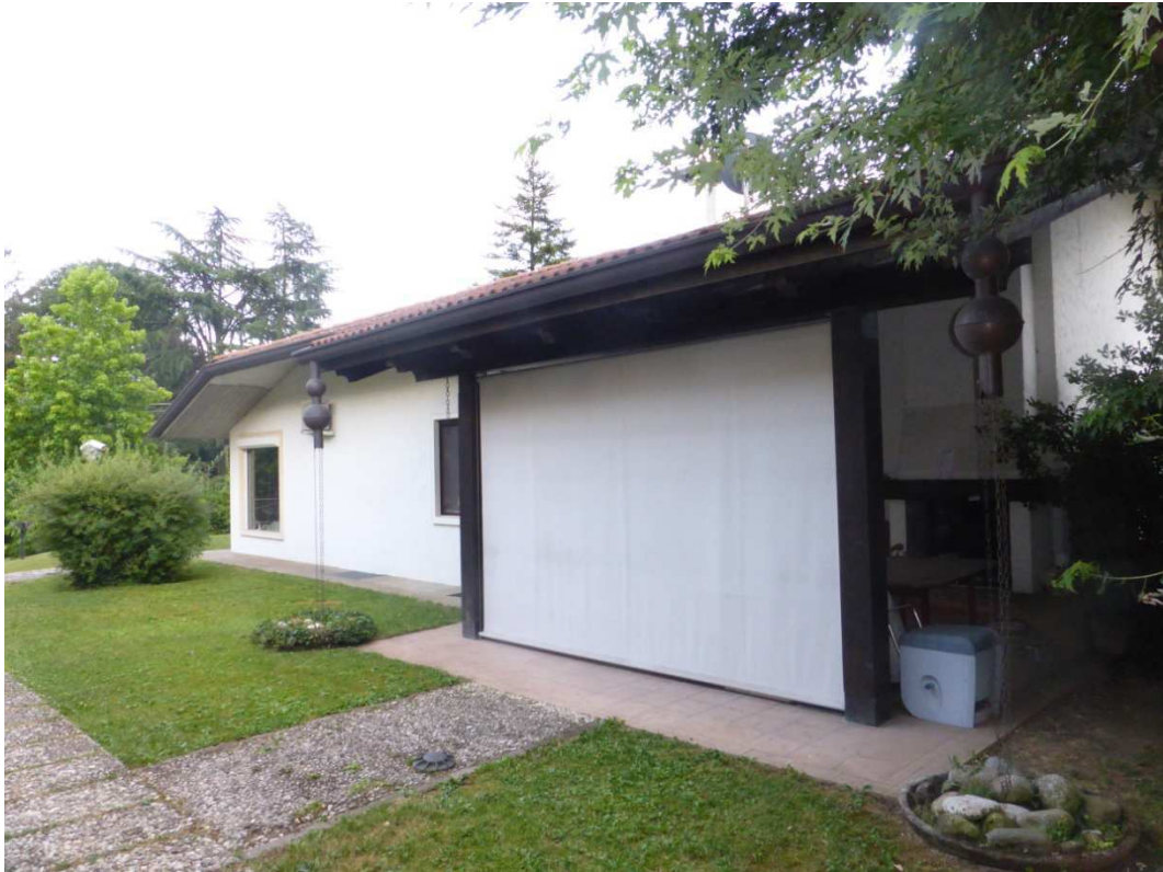
Foto 5: Vista prospettica del fabbricato immobiliare, lato Nord-Ovest.
