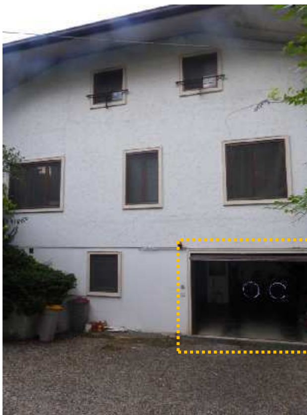
Foto 7: Vista prospettica del fabbricato immobiliare, lato Sud-Ovest – Garage (poligono giallo).
