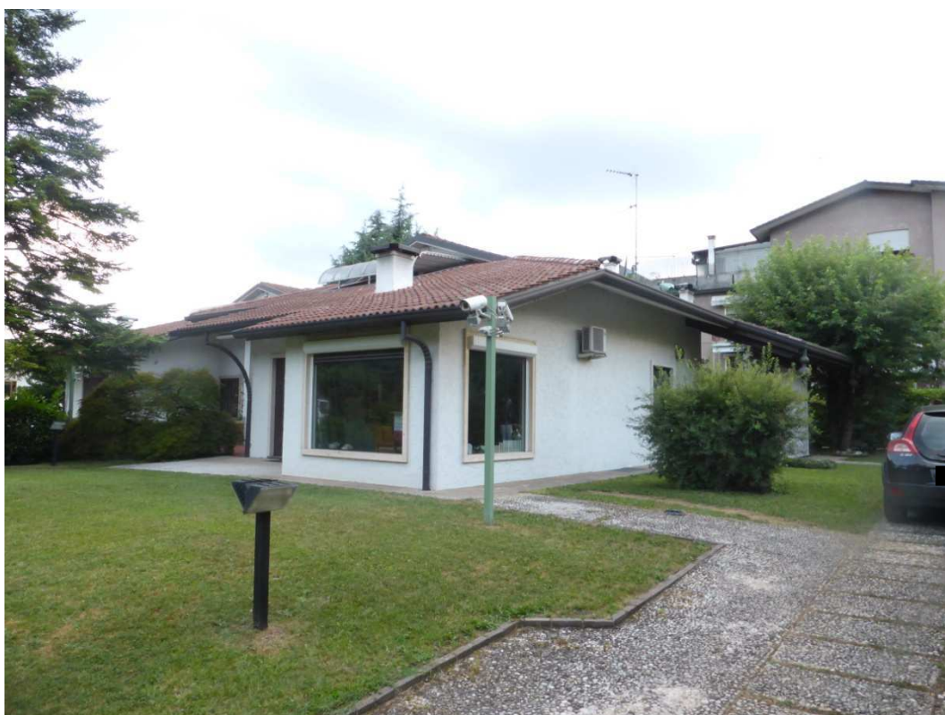
Foto 4: Vista prospettica del fabbricato immobiliare, lato Nord-Ovest.
