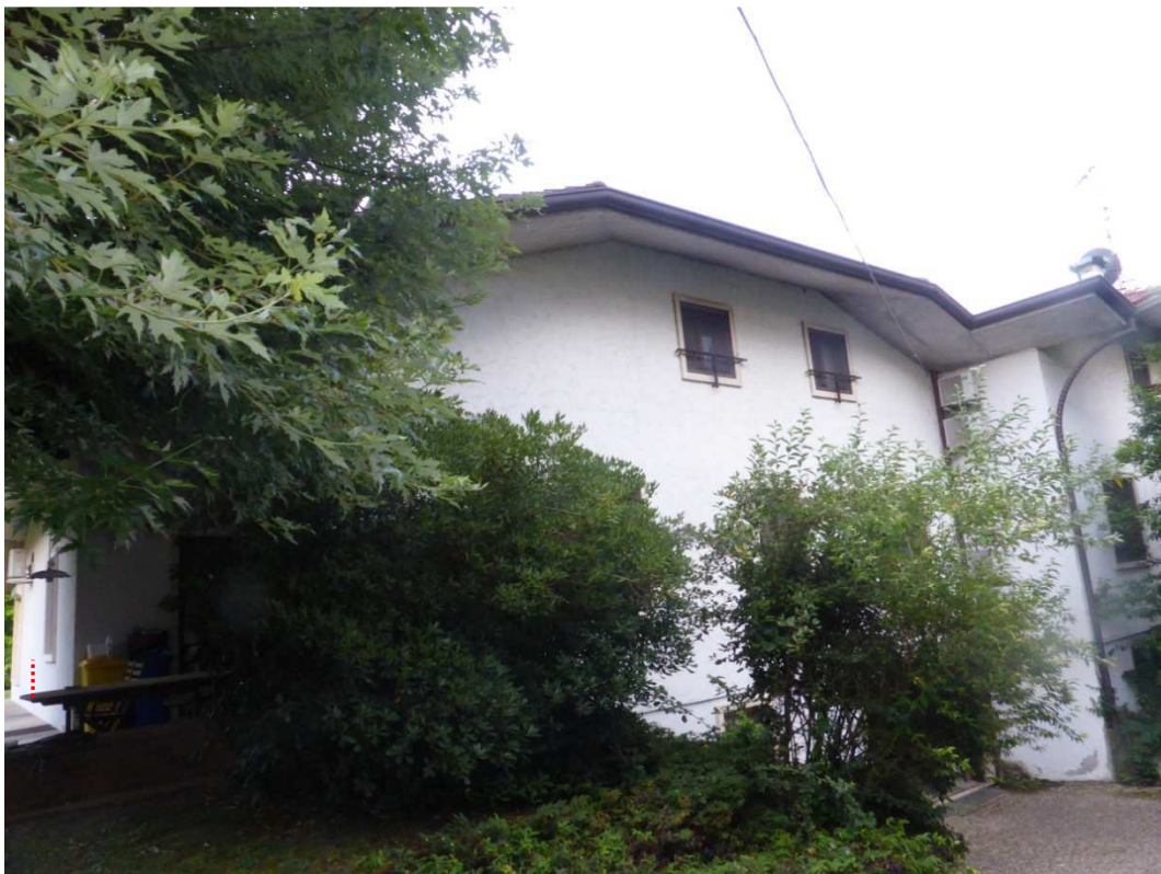
Foto 6: Vista prospettica del fabbricato immobiliare, lato Sud-Ovest.
