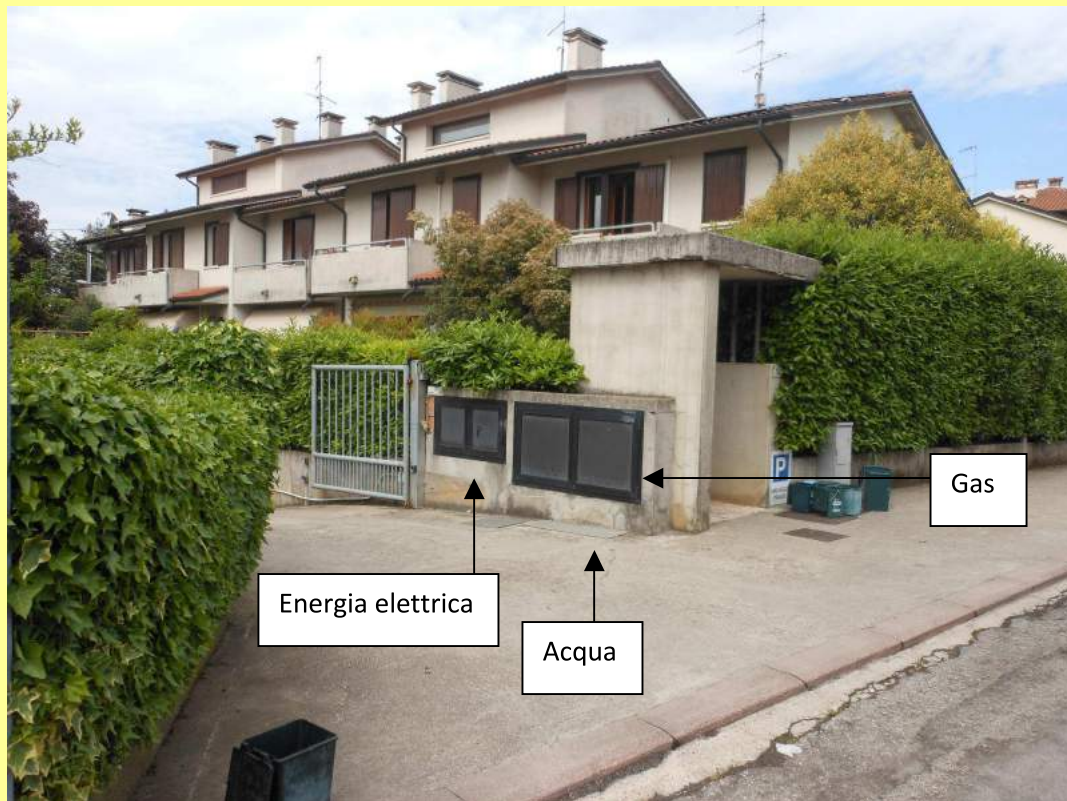
Figura 13 – Immagine del blocco contatori acqua, interrati, energia elettrica e gas
