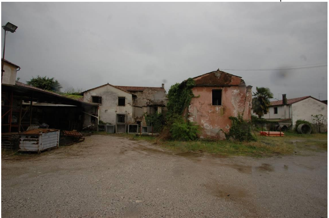
Altri fabbricati ad uso residenziale
