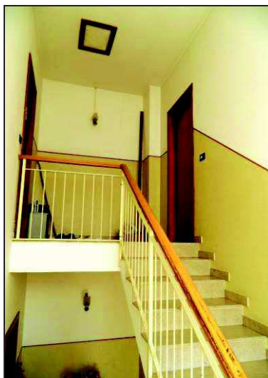
VANO SCALA – ACCESSO APPARTAMENTO
