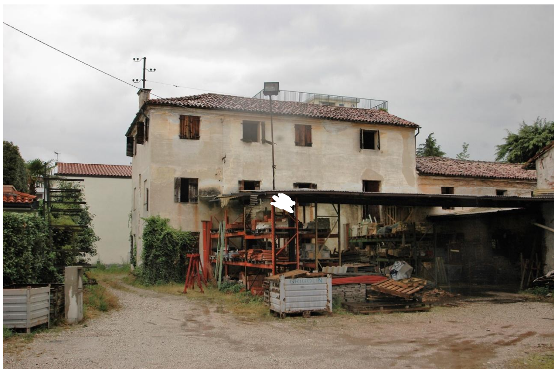
VISTA ESTERNA TETTOIA
