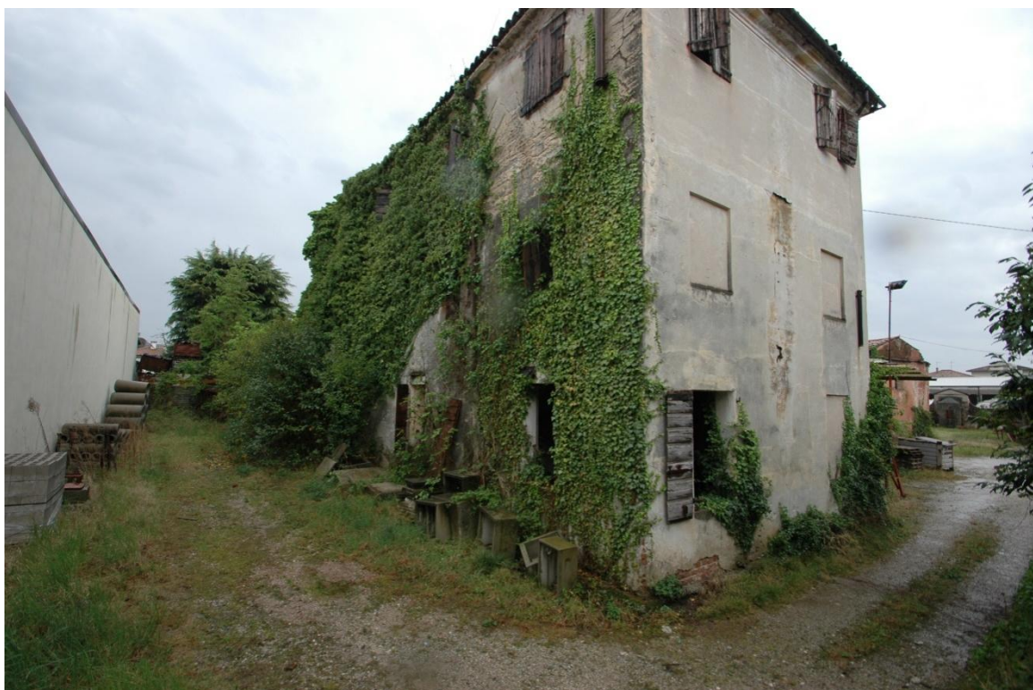
VISTA DA NORD EDIFICIO AD USO RESIDENZIALE IN DISUSO
