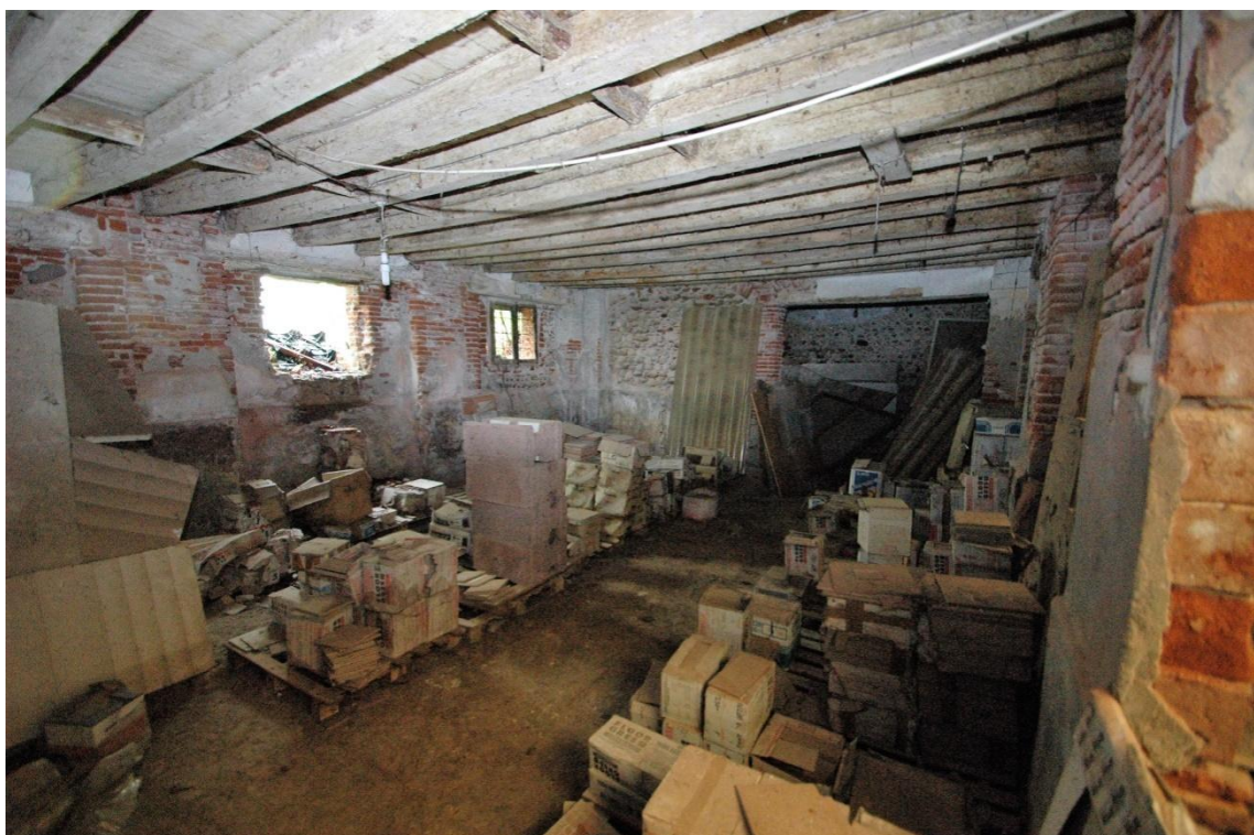
INTERNO EDIFICIO AD USO RESIDENZIALE UTILIZZATO COME MAGAZZINO
