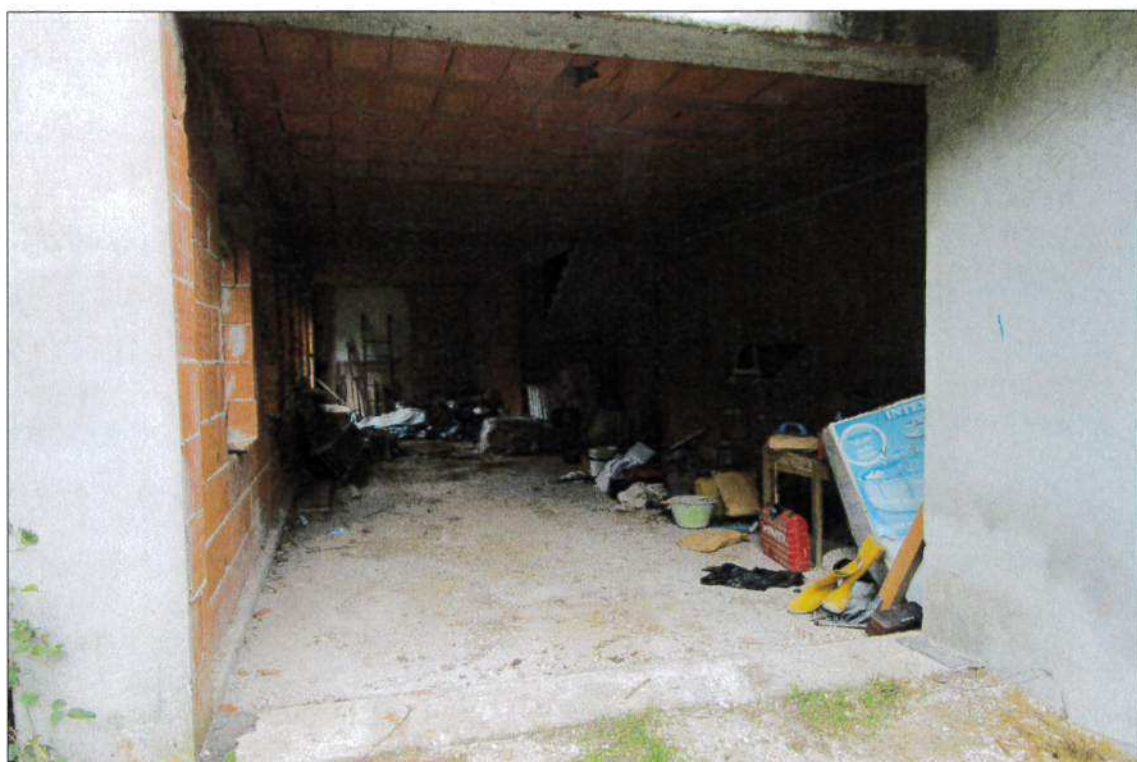
LOCALI AL PIANO TERRA
