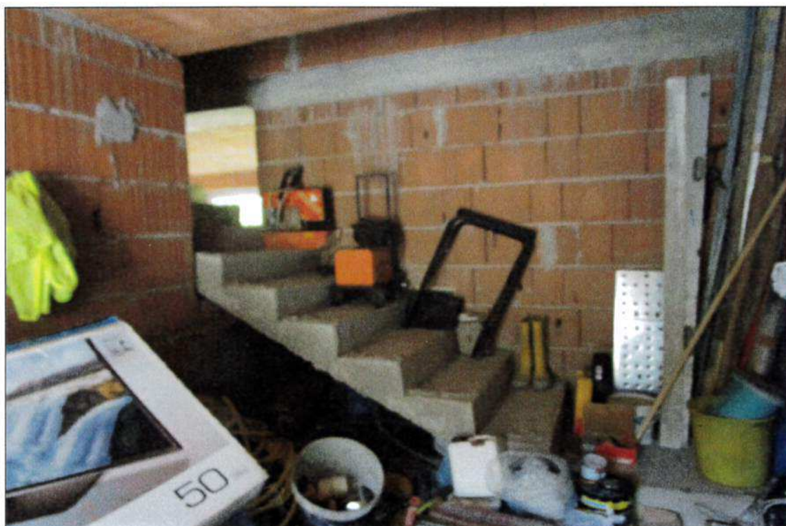
LOCALI AL PIANO TERRA
