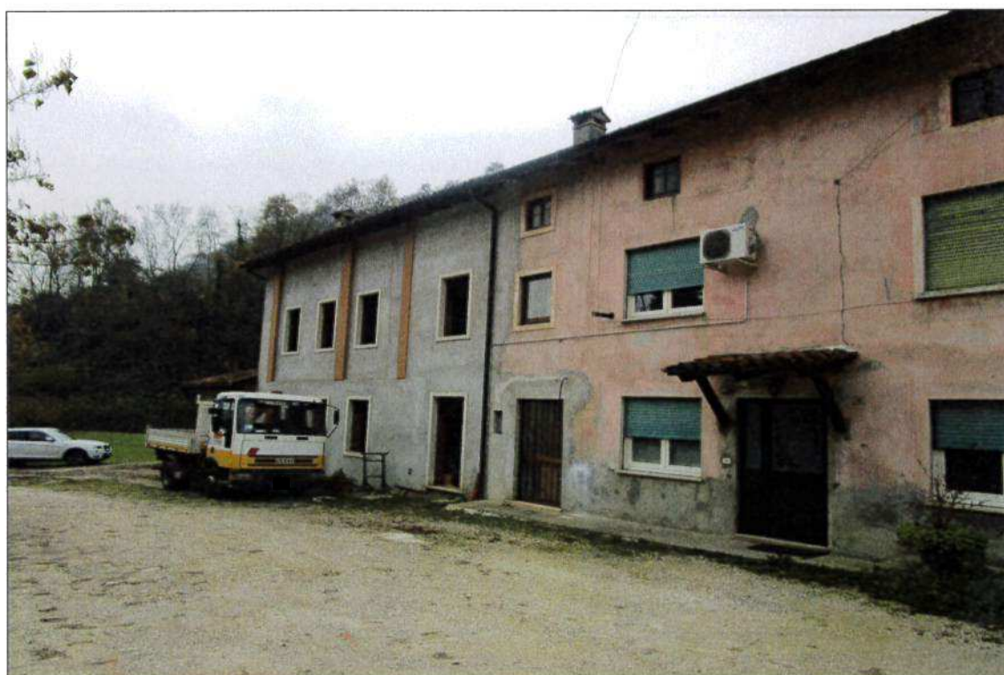
VISTA ESTERNA NORD-EST
