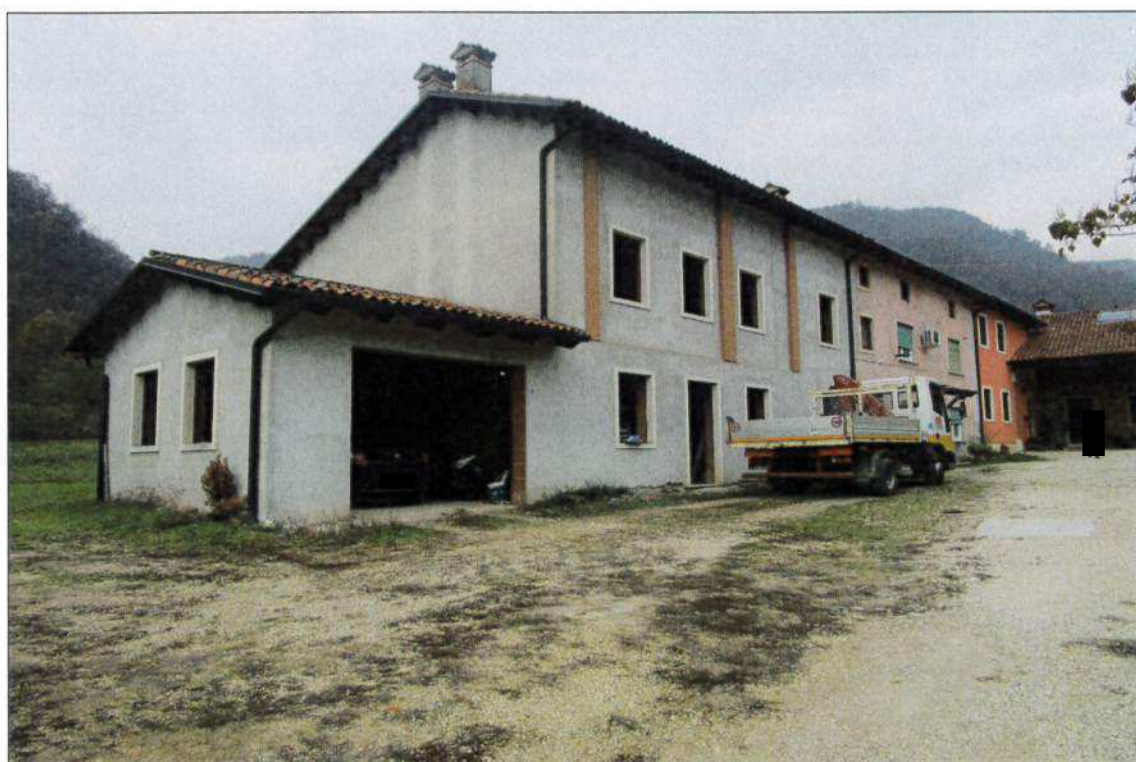
VISTA ESTERNA SUD-EST
