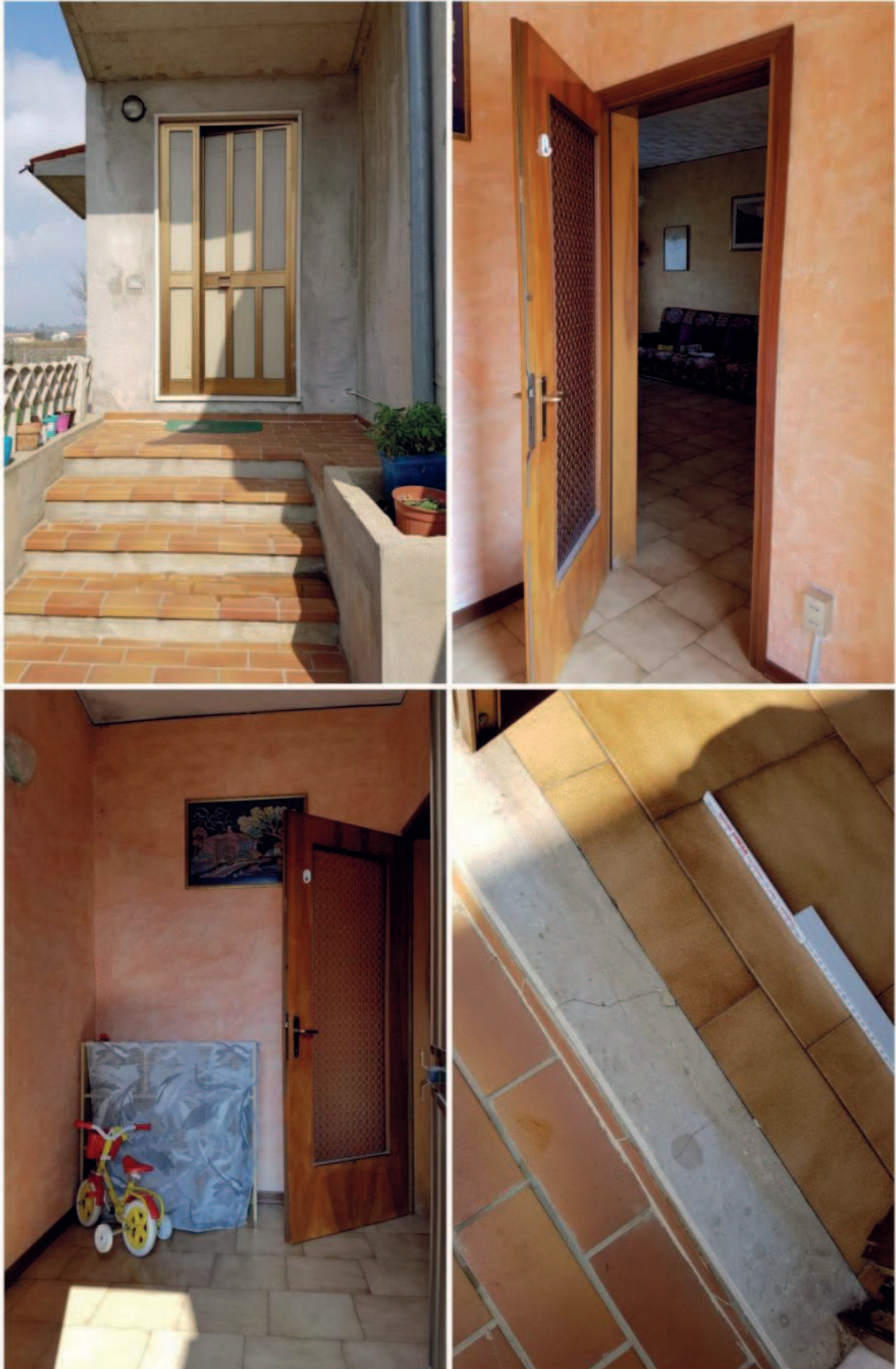
ingresso bussola e particolari
