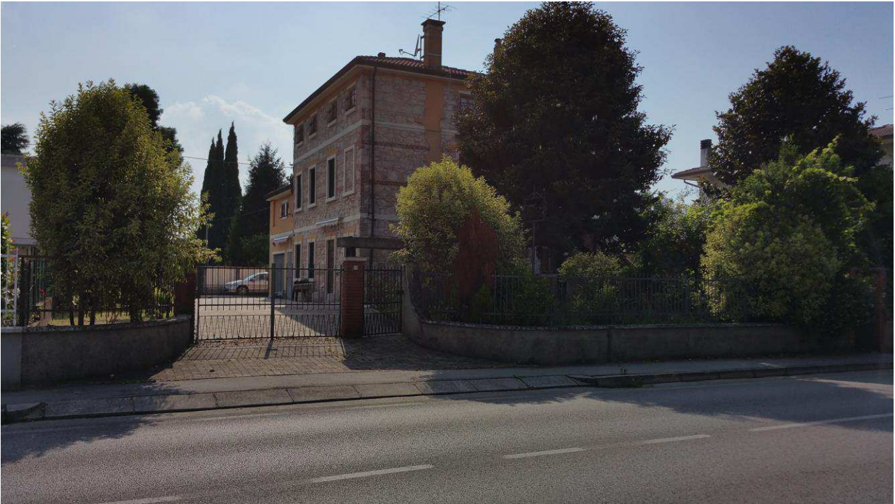
Foto n°1 –vista fabbricato da via Dante Alighieri
