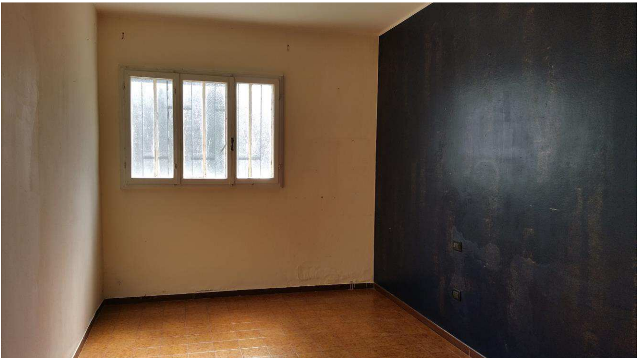
Foto n°16 – vista locale cantina al piano terra
