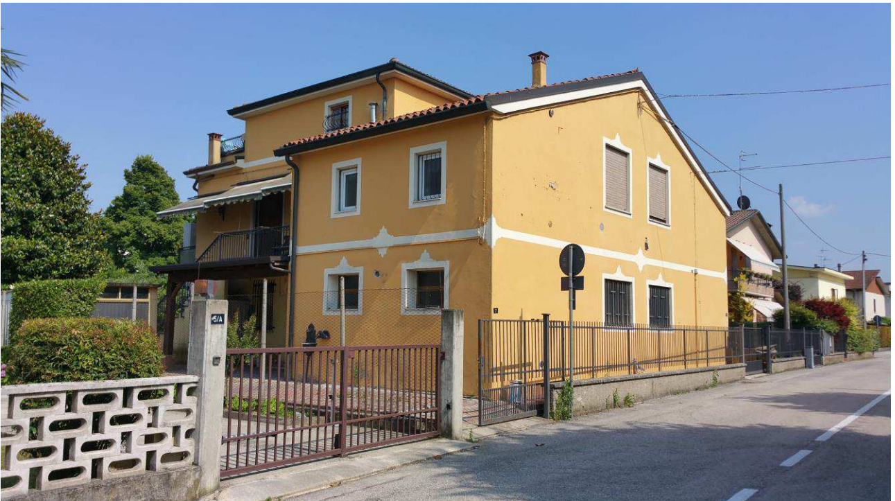
Foto n°4 – vista prospetti nord ed ovest
