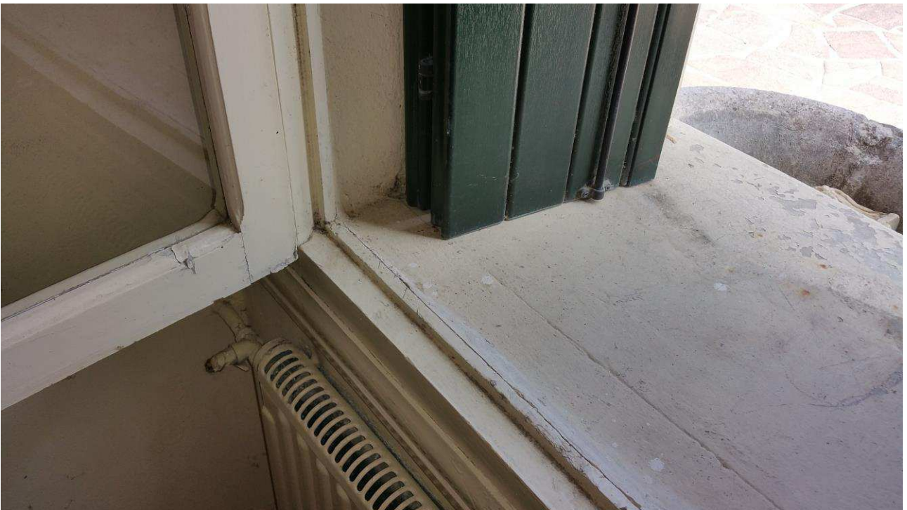
Foto n°18 – vista particolare serramento e davanzale
