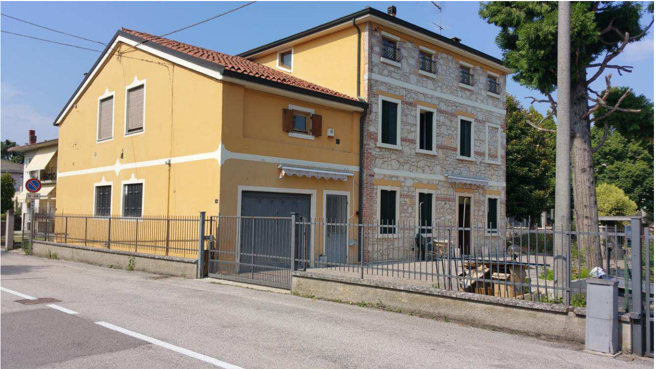
Foto n°3 – vista prospetti sud ed ovest
