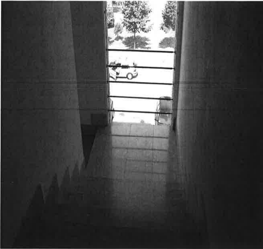
VISTA DELLA RAMPA
