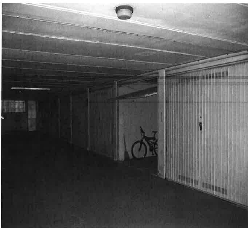
VISTA ESTERNA BOX
