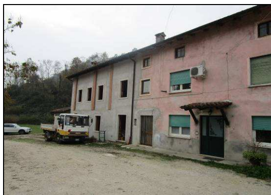
Vista esterna nord-est
