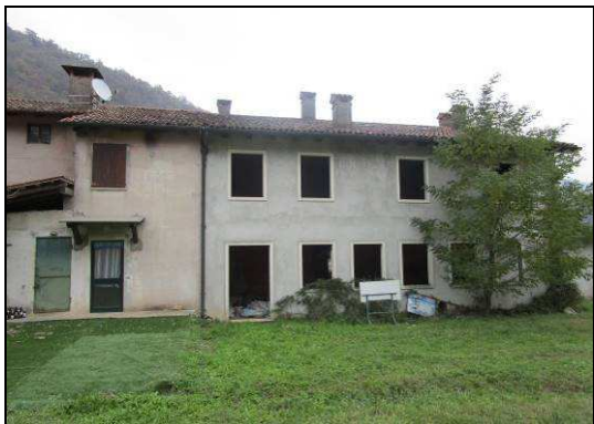
Vista esterna ovest
