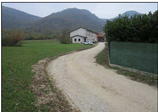
Vista esterna sud-est (strada di accesso)
