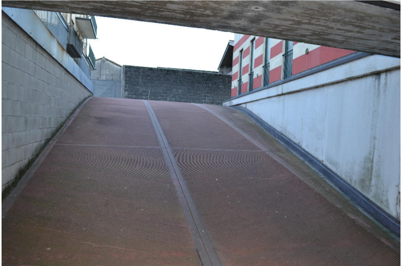
Figura 16 – Accesso condominiale ai garages interrati
