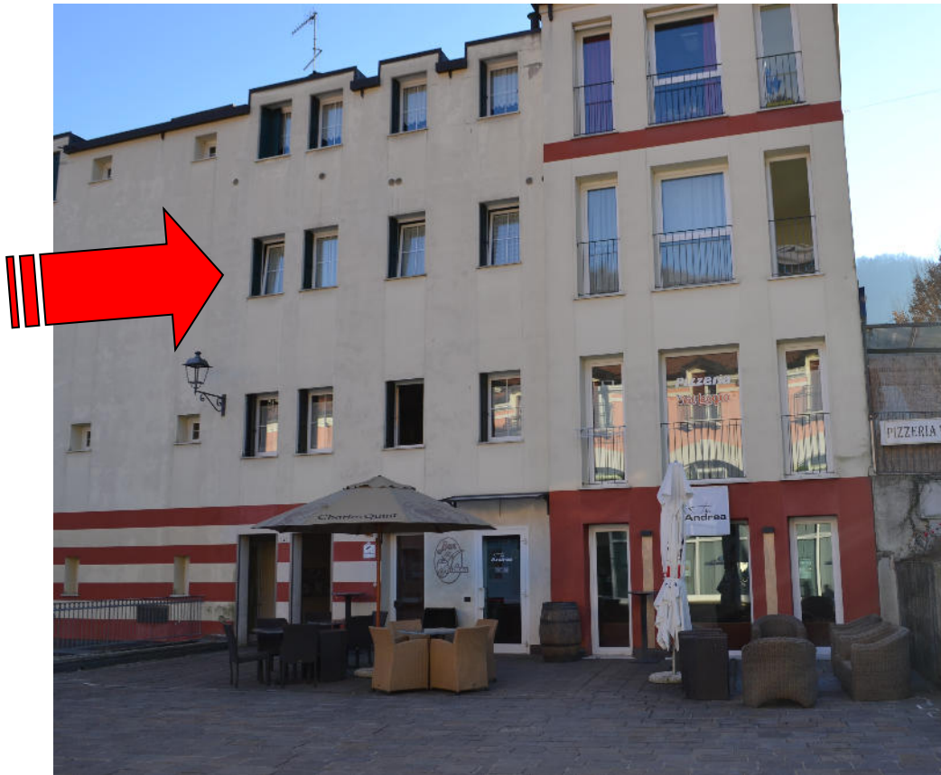
Figura 3 – Vista d'insieme condominio
