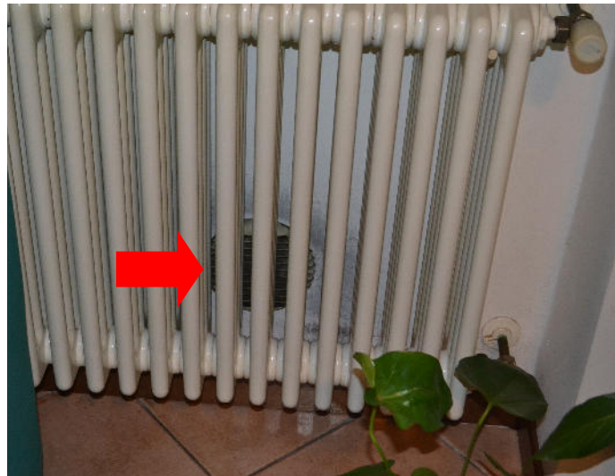
Figura 6 – Presa d'aria inferiore
