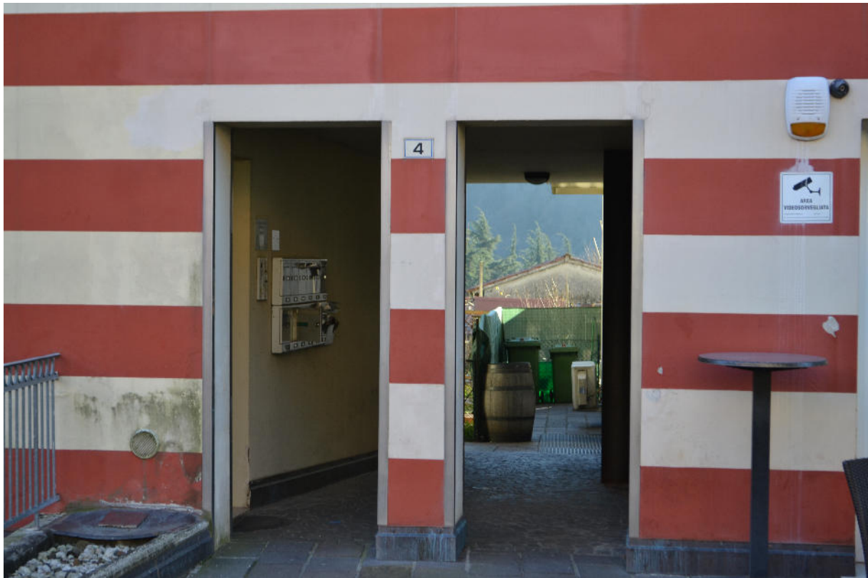
Figura 4 – Accesso condominiale piano terra
