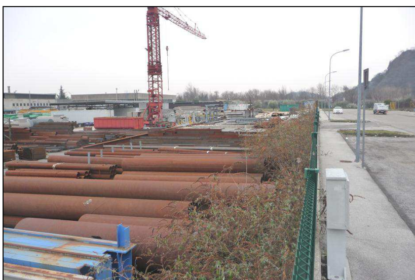
Foto n. 3 (vista area nord)
