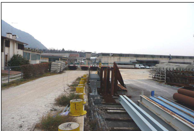
Foto n. 5 (vista area nord)
