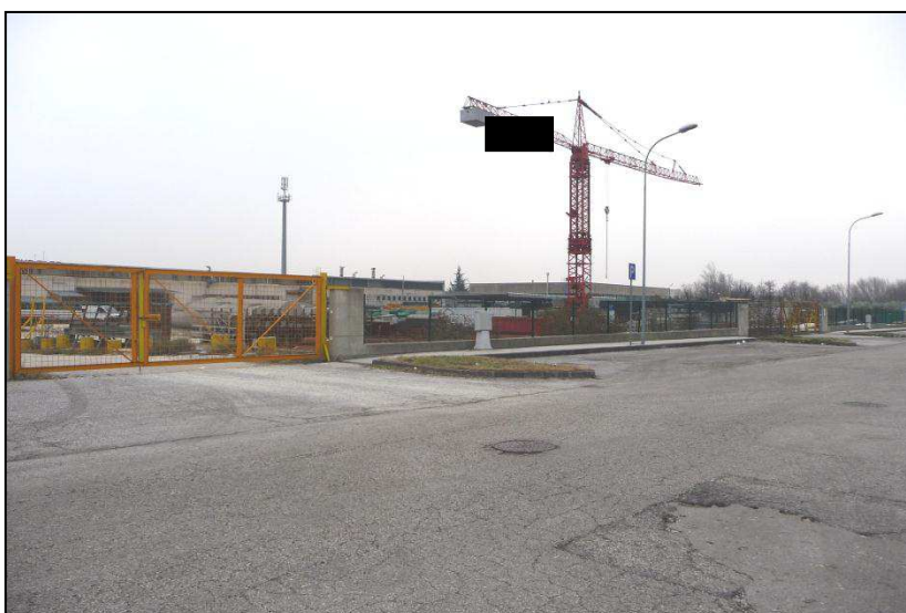
Foto n. 6 (vista area nord)
