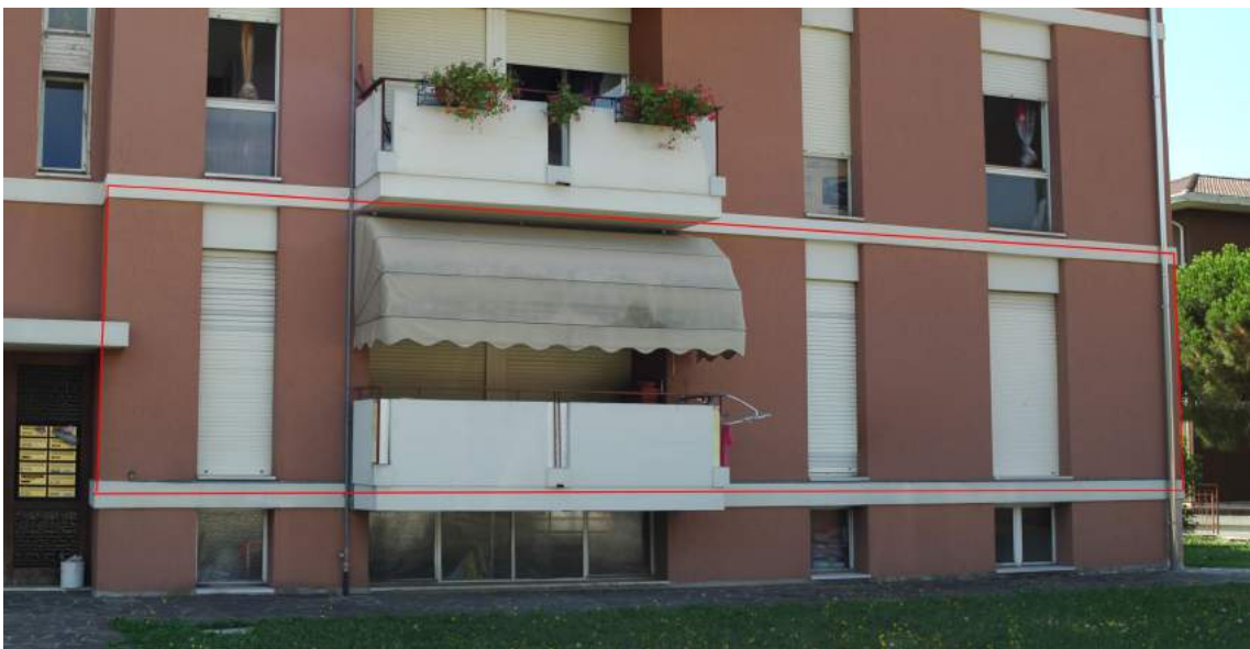
Foto 03 – Vista lato Nord – Unità evidenziata
