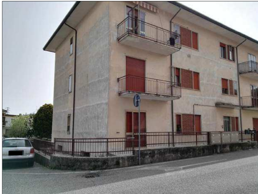
FOTO 1 - Fronte principale dell'edificio (Via Lombardia)
