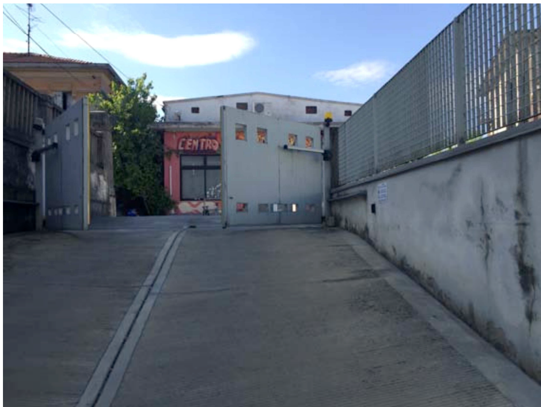
Foto n. 7 (vista accesso carraio e scivolo)
