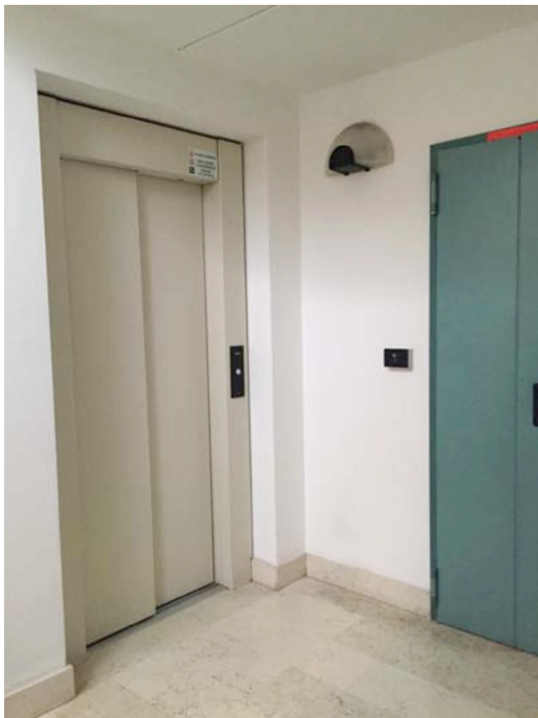
Foto n. 5 (vista accesso interno autorimesse e ascensore)
