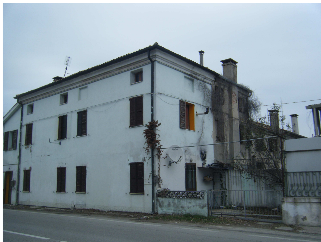
Foto n. 2 (vista prospetto principale ovest su via Godicello con accesso alloggio)
