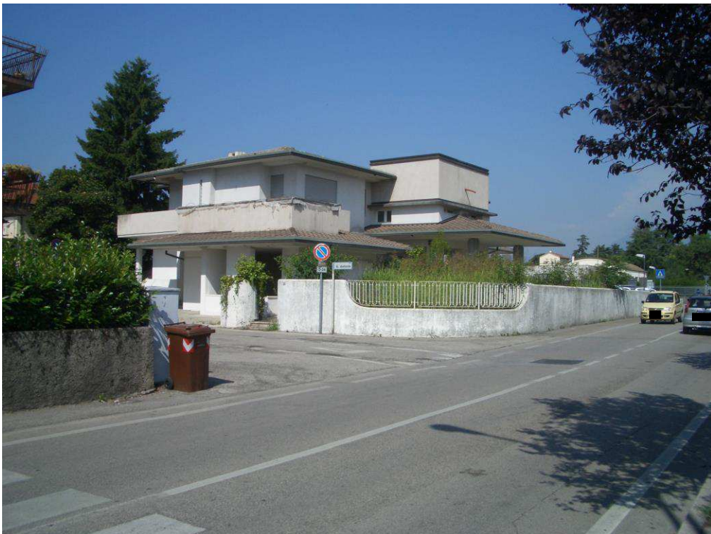
2. Vista da Nord-Est
