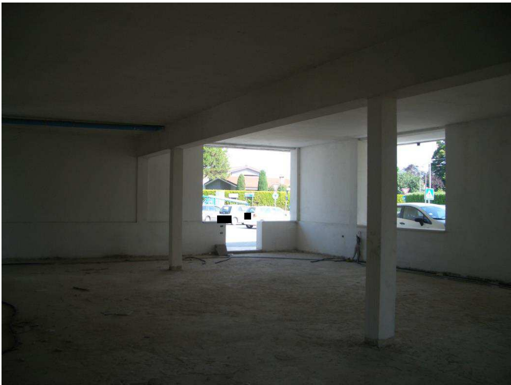
6. Vista piano terra, subalterno 64
