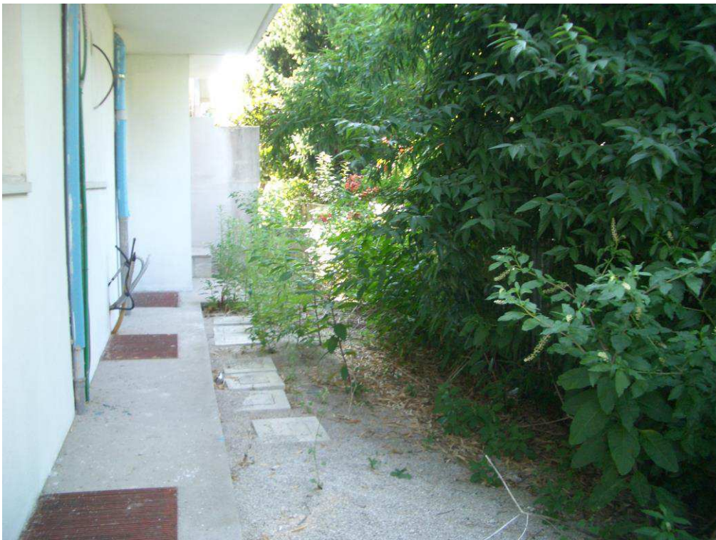
8. Vista piano terra, subalterno 64
