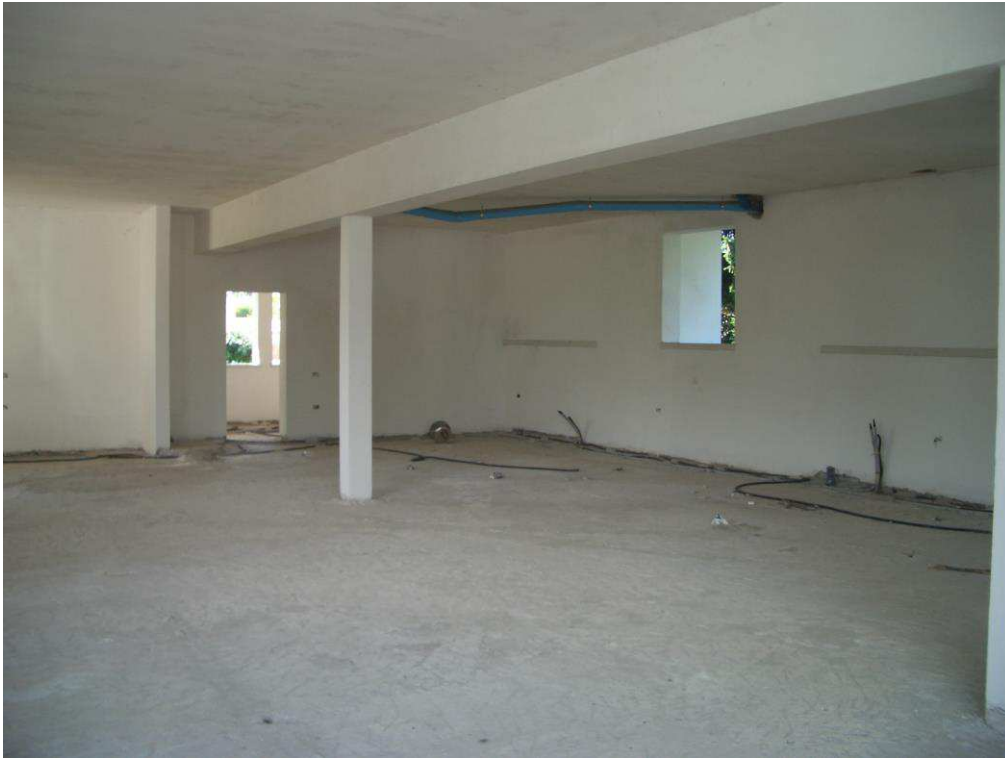
7. Vista piano terra, subalterno 64
