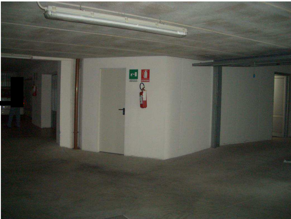
4. Vista piano interrato, subalterno 56
