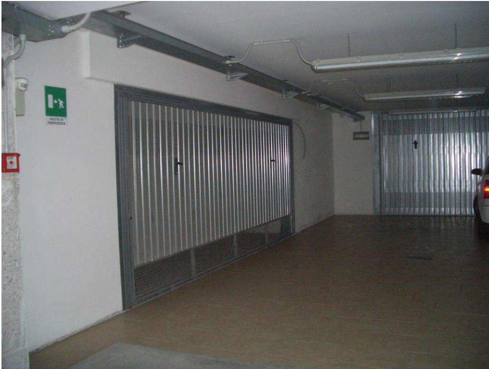
5. Vista piano interrato, subalterni 21 e 66
