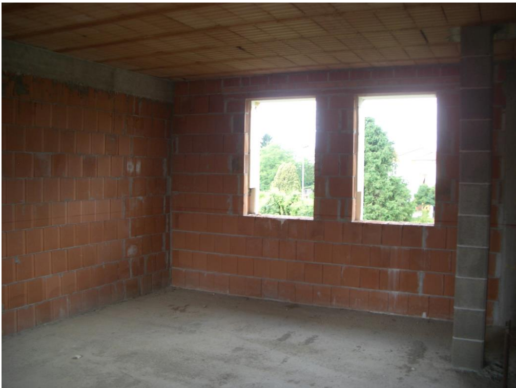
4. Vista interna piano primo
