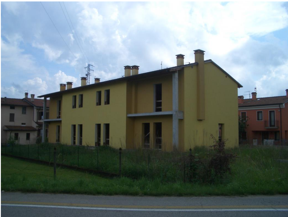
2. Vista generale da Est
