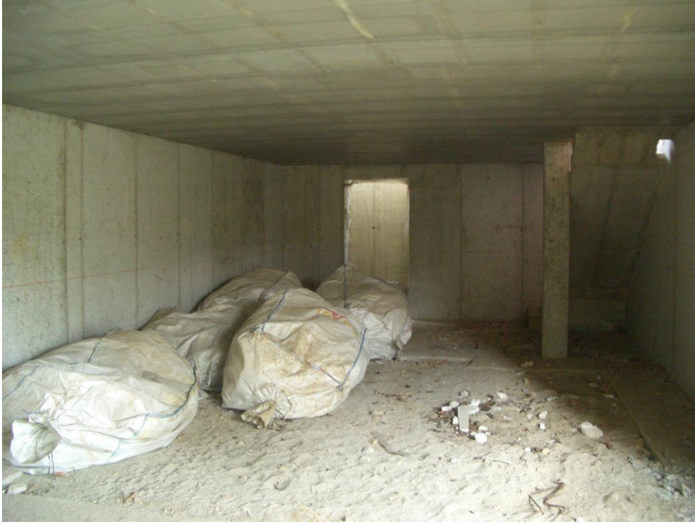
5. Vista interna piano interrato
