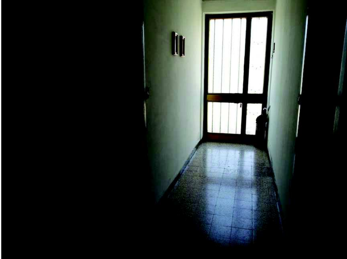
Foto n°11 – Immobile A – vista ingresso al piano terra
