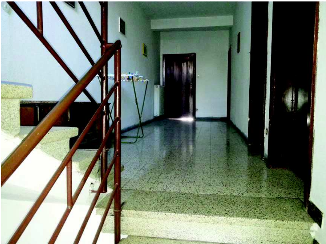
Foto n°16 – Immobile A – vista disimpegno al piano primo
