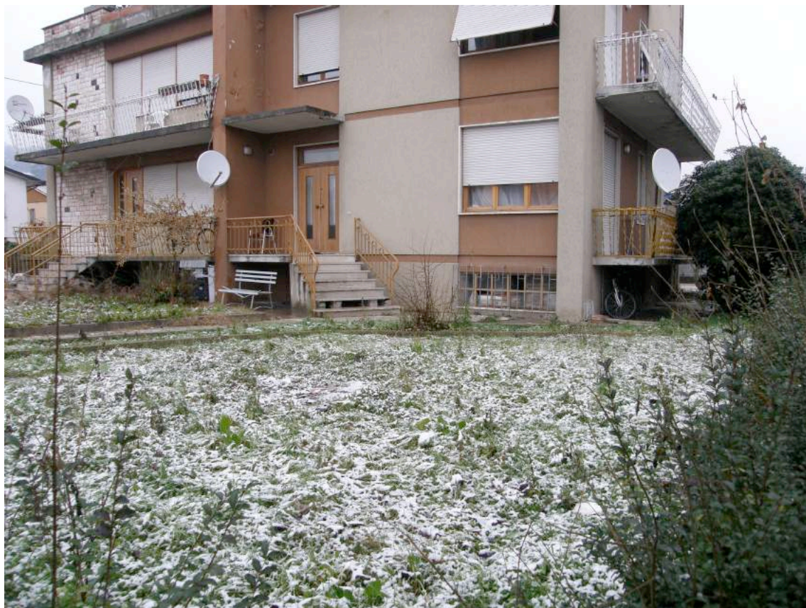
Foto 3 piano terra, immobile esecutato – entrata e corte esclusiva – da sud
