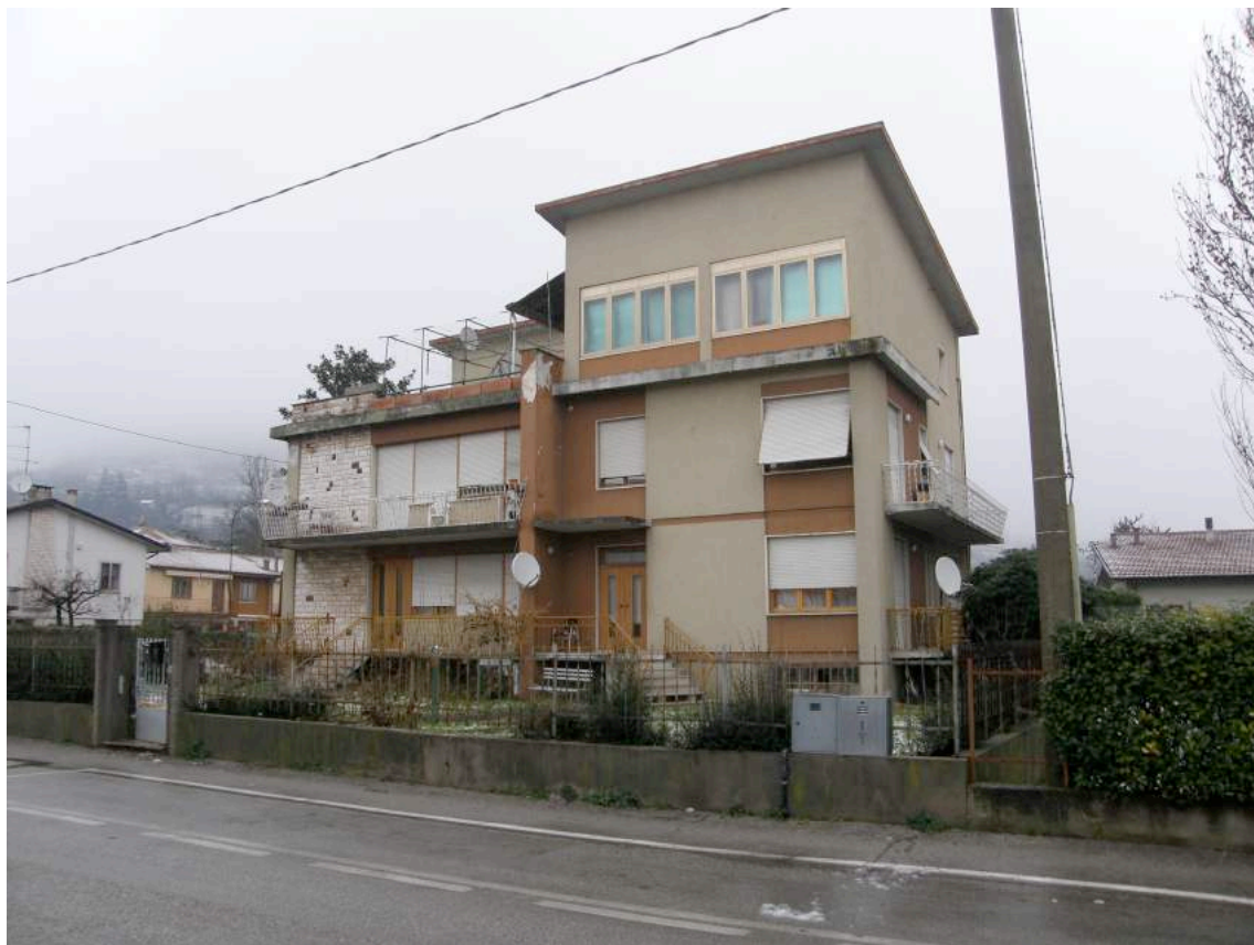
Foto 1 immobile condominiale – da sud
