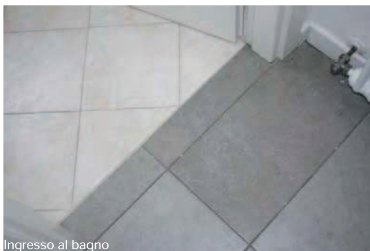
Soglia di ingresso
