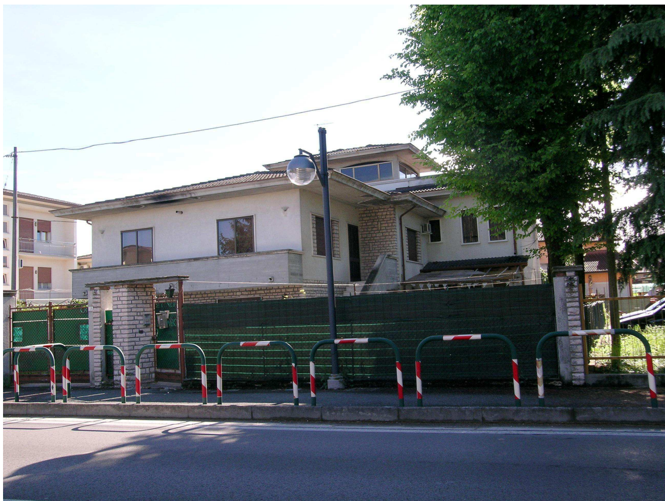
Vista dell' immobile da via Marosticana
