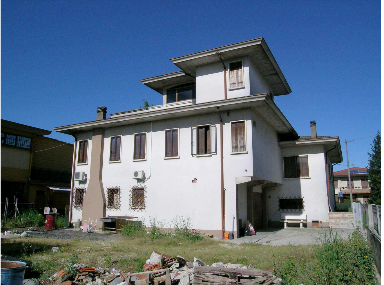
Vista del fronte est
